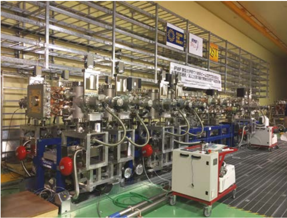
b. Il primo stadio dell'impianto IFMIF-EVEDA, realizzato dall'INFN e installato a Rokkasho (Giappone).
